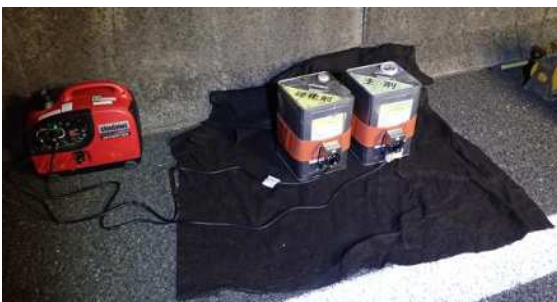
写真-4 バンドヒーター取付け状況及び毛布による保温状況
