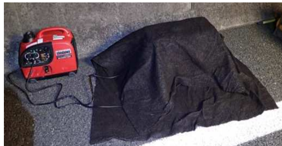
写真-4 バンドヒーター取付け状況及び毛布による保温状況
