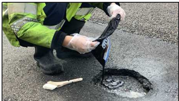
写真-2 仮埋め施工（はつり無し）
