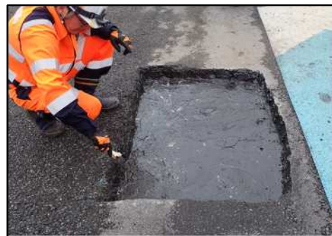
写真-3 平面的施工（はつり有り）
